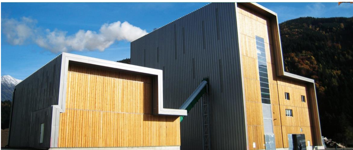
Die fertig gestellte Biomasseanlage:
