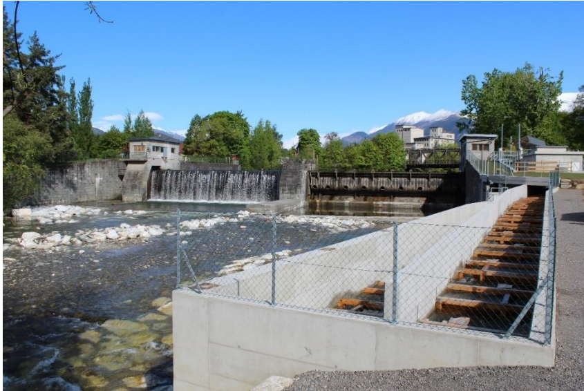
Abbildung 2 Ansicht des Kraftwerkes inkl. der Fischaufstiegshilfe, die im Rahmen der Neuerrichtung der Kraftwerksanlage gebaut wurde. © Hasslacher Gruppe
