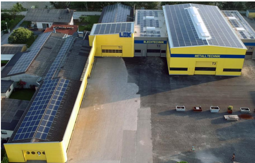
PV Stahlbau Lex Gratkorn
