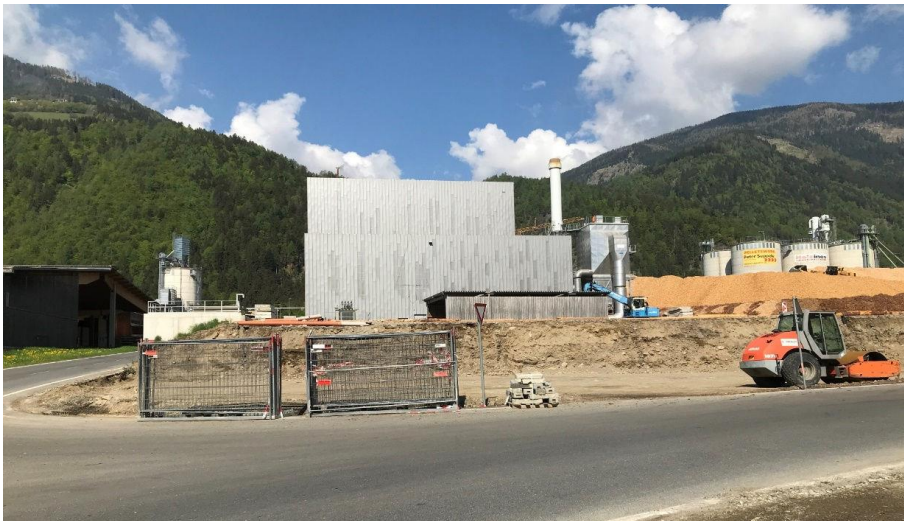
Die Baustelle vor Errichtung der Biomasseanlage:
